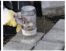
Betonpflaster hammerfest setzen, Frisch-in-frisch-Verlegung
