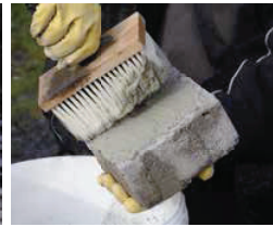
Belagsunterseite mit Kontaktschlämme einstreichen
