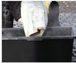
Bettungsmörtel vorlegen, Wasser zugeben und anmischen
