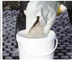
Kontaktschlämme vorlegen, Wasser zugeben und anmischen
