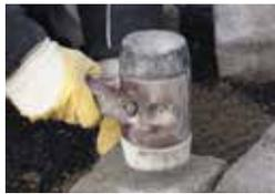
**Pflaster in Drain-Bettungsmörtel hammerfest setzen**
