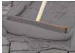
**Zementmörtel mit Gummischieber einbringen**
