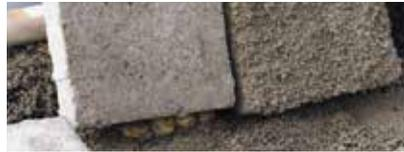
**Nur unter Einsatz der Kontaktschlämme erzielen Sie einen vollständigen Haftverbund zwischen Betonstein und Bettungsmörtel!**
