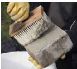
Belagsunterseite mit Kontaktschlämme einstreichen
