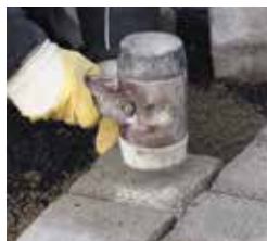
Pflaster in Drain-Bettungsmörtel hammerfest setzen
