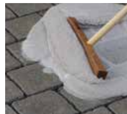
Eimerinhalt mit Gummischieber einbringen
