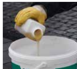
Bindemittelkomponente zugeben und homogen aufrühren
