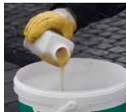
**Bindemittelkomponente zugeben und homogen aufrühren**
