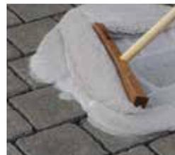
**Eimerinhalt mit Gummischieber einbringen**
