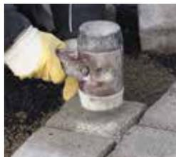
**Pflaster in Drain-Bettungsmörtel hammerfest setzen**
