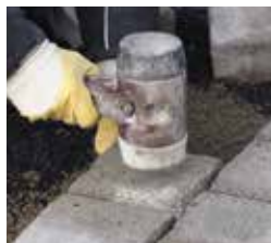
Pflaster in Drain-Bettungsmörtel hammerfest setzen
