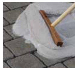
Eimerinhalt mit Gummischieber einbringen
