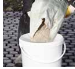
Kontaktschlämme vorlegen, Wasser zugeben und anmischen
