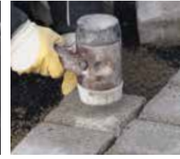
Betonpflaster hammerfest setzen, Frisch-in-frisch-Verlegung
