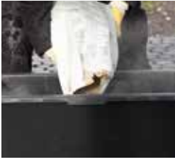
Bettungsmörtel vorlegen, Wasser zugeben und anmischen
