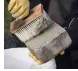
Belagsunterseite mit Kontaktschlämme einstreichen
