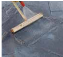
Mörtel mit Hartgummischleiber und Wassersprühstrahl einarbeiten und sauber abspülen
