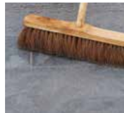
Letzte Mörtelreste ggf. mit Kokosbesen entfernen
