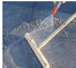
Fugenmörtel einfügen
