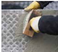
Plattenunterseite mit Kontaktschlämme versehen und „frisch in frisch“ verlegen
