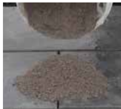
Mörtel portionsweise aufbringen
