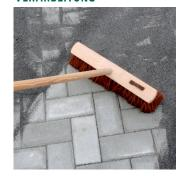
DustLo Fugensand in das trockene Pflaster einfegen und von der Oberfläche abfegen.
