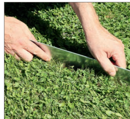
Schritt 6: Profile nacheinander einbringen, mit Hilfe eines Gummi- oder Kunststoffhammers auf die gewünschte Höhe ausrichten.*
