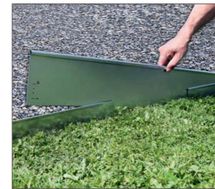
Schritt 1: Lücke zwischen den Rasenkanten. Endmaß nicht erreicht.
