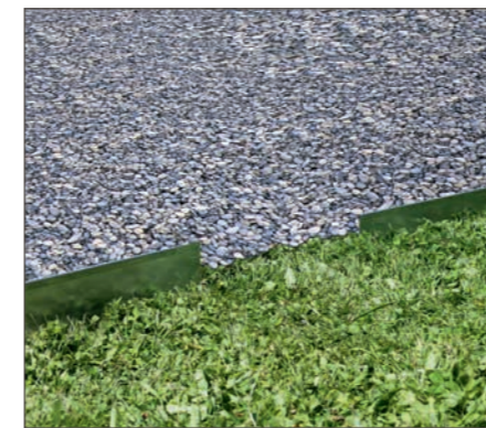
Schritt 1: Lücke zwischen den Rasenkanten. Endmaß nicht erreicht.
