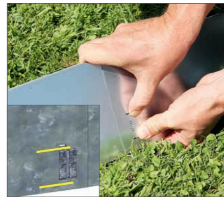
Schritt 4: Die Montageklammer mit beiden Daumen gleichmäßig bis zum Anschlag schieben.
