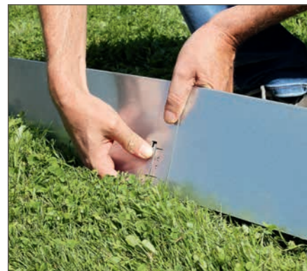
Schritt 3: Die Rasenkanten werden mit Hilfe des Klammersystems einfach und schnell montiert.
