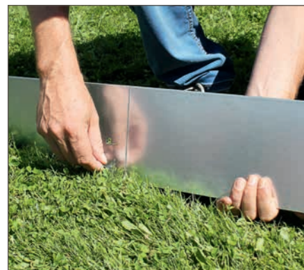
Schritt 1: Zwei Rasenkanten zusammenstecken.
