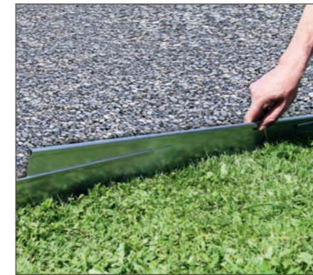
Schritt 3: Abschlussstück aufsetzen (2).
